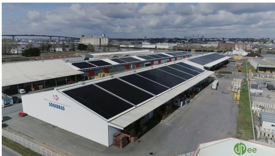
Exemple de hangars solarisés sur Nantes Métropole. Crédits JPee
